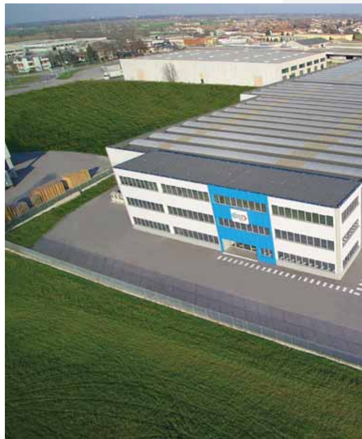
Argo - huvudkontoret i Alfianello, logistikcenter och projektledningskontor
