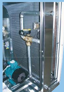
BRT 2/3-raders vattenbatteri med 3-vägsventil
