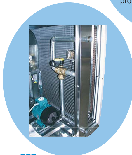
BRT tvåraders vattenbatteri med 3-vägsventil
