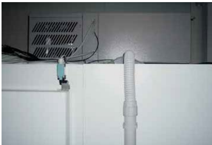
Montering av kylaggregat ovanpå kylrumstak.
