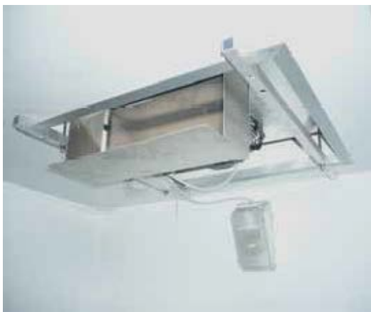
Fastsättning av kylaggregat i tak sedd inifrån kylrummet.
