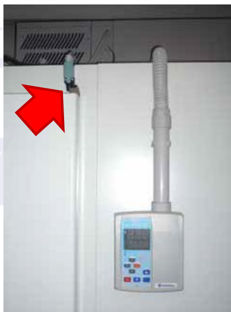
Dörrbrytare som stoppar fläkten vid dörröppning.
