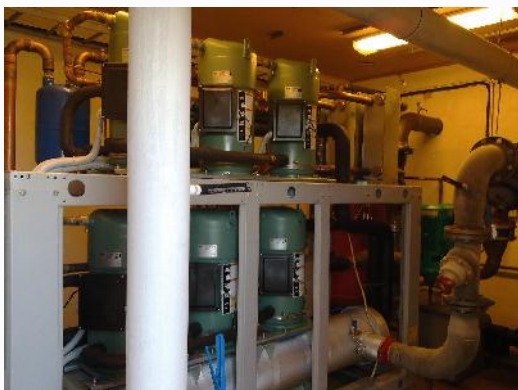
Vätskekylt vätskekylaggregat, Venco Volkswagen Groups testbana, Arjeplog
