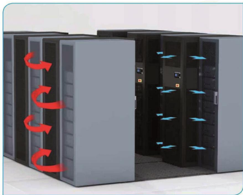
Version för i-rack installation med främre och tvärgående lufttillförsel.
